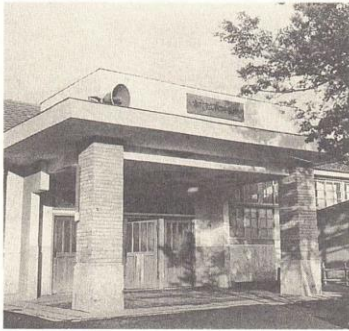
正面玄関 昭和27年3月竣工
