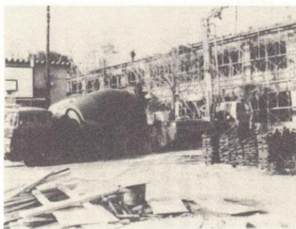
工事進む新校舎
